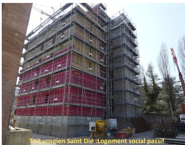
Lors de la construction d'immeuble, des caissons remplis de paille, sont installés à l'extérieur contre les murs en bois pour obtenir des immeubles passifs. Cette technique des caissons est facile à mettre en œuvre et demande peu d'immobilisation...
