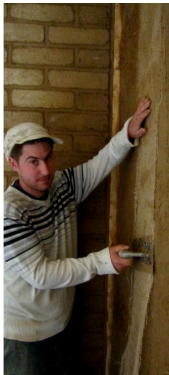
Fabrication et pose d'éco-matériaux pour les gîtes de Landrethun le Nord
